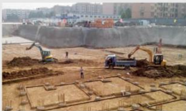
济南世茂国际广场基坑监测
