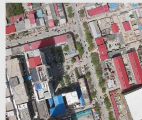
新旧动能转换区部分拆迁片区冻结影像
