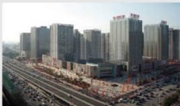
济南万达广场项目竣工测量
