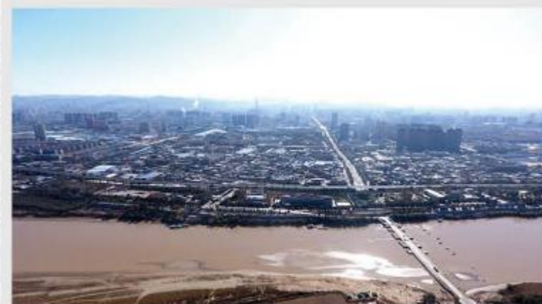
新旧动能转换区改造房产测绘地上物清点及面积测绘
