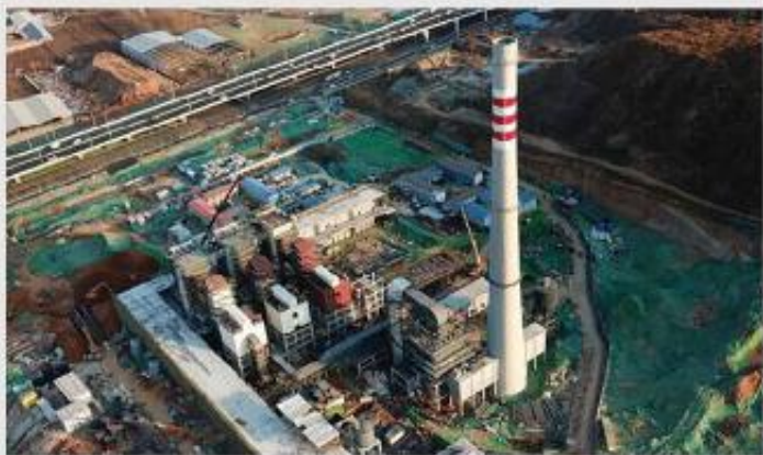
济南腊山热源厂地质灾害评估项目
