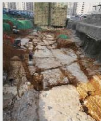
基底物探现场探测
